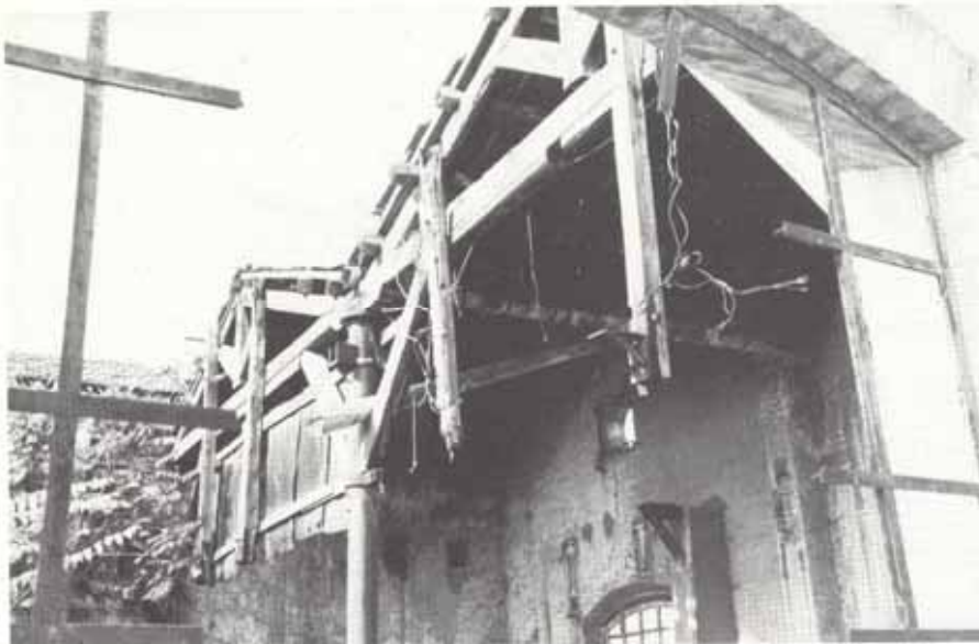
Magazzino con coperture in legno
